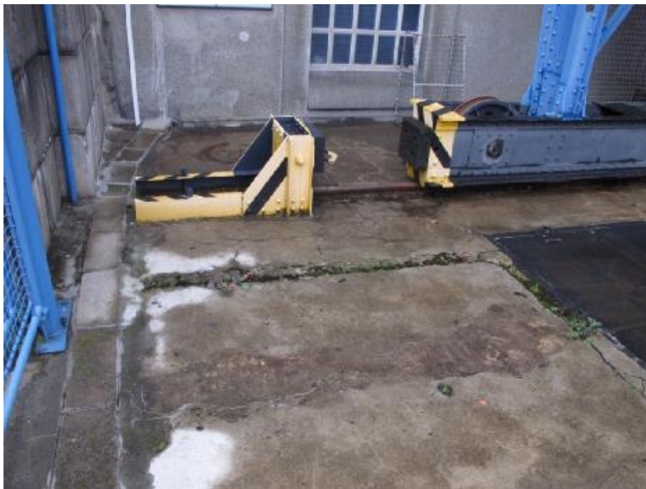
Degradace betonu na ploše plata
