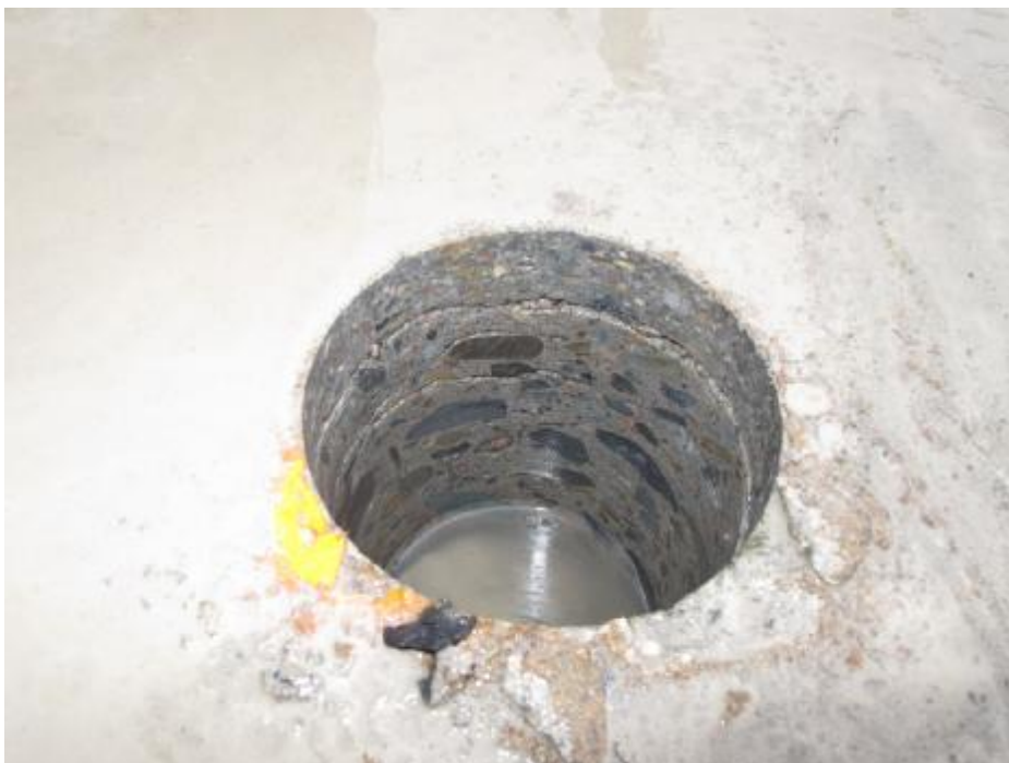
Vrt s patrným oddělením svrchní vrstvy cementové mazaniny
